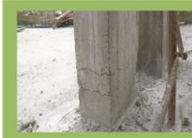
Sono evidenti le fessure nel c.a. nel pilastro senza il Sistema Midollo®
